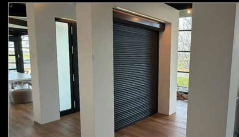
Installation contre le châssis
