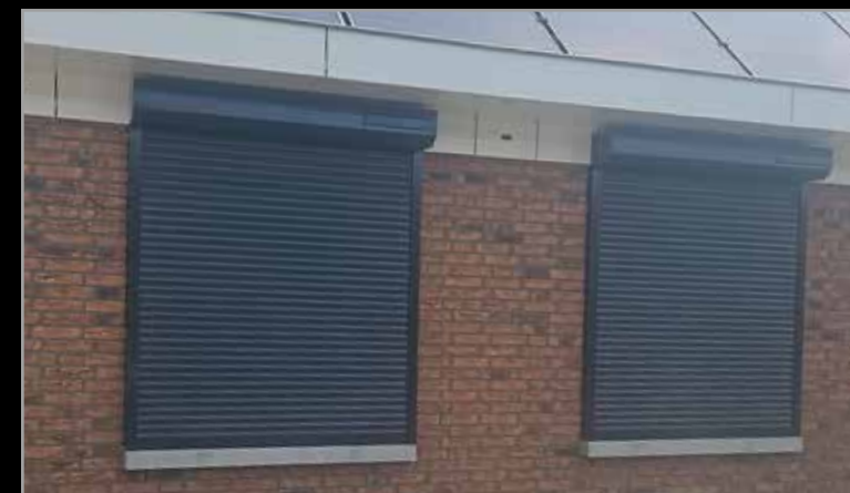
Installation contre le mur
